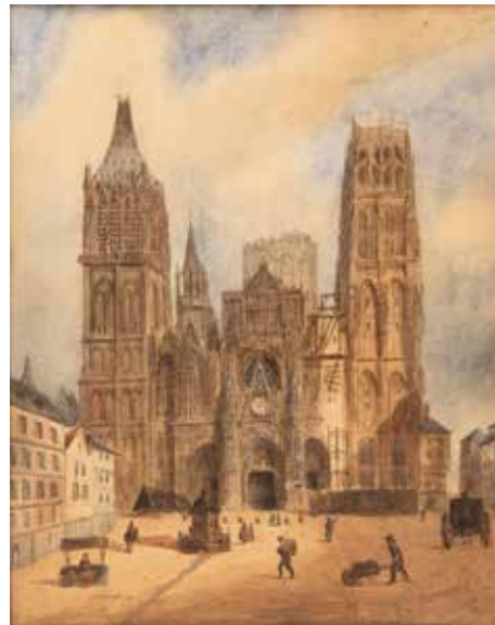
n° 41 : Vue animée de la cathédrale de Rouen pendant les travaux du XIX e siècle.
